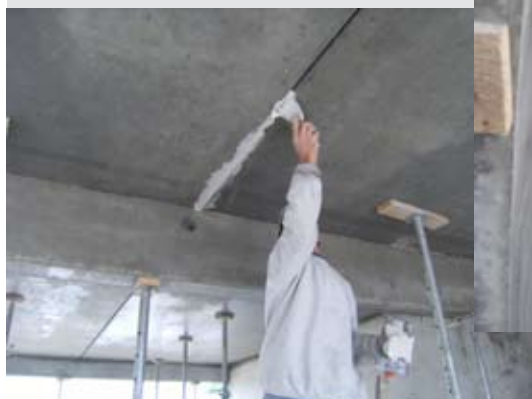
Garnissage du joint
