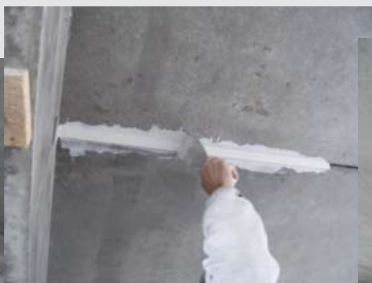
Remplissage et arase du joint
