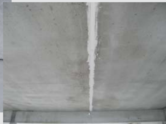
Lissage du joint pour une finition lisse
