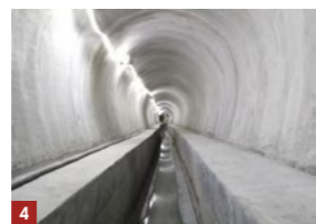
4 > Rendu après projection de mortier
