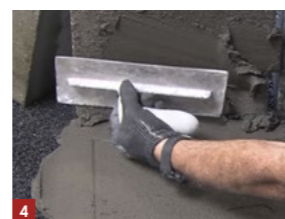
4 > Pré-encoller l'élément à coller
