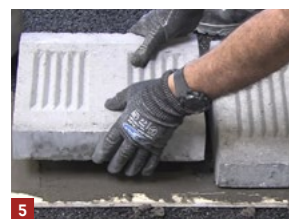
5 > Positionner l'élément
