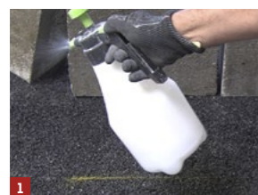
1 > Nettoyer et humidifier le support
