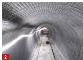
2 > Installation d'un treillis
