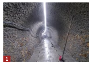
1 > Purge de l'ouvrage
