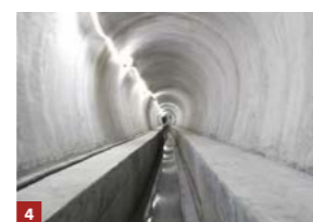
4 > Rendu après projection de mortier
