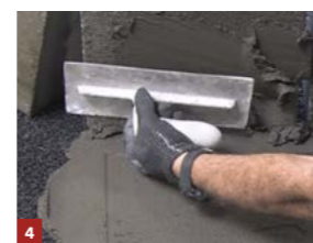
4 > Pré-coller l'élément à coller
