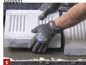
5 > Positionner l'élément
