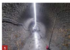
1 > Purge de l'ouvrage
