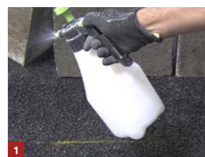
1 > Nettoyer et humidifier le support
