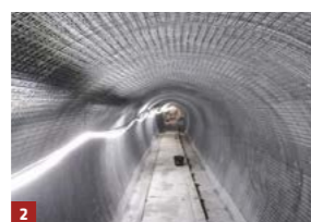
2 > Installation d'un treillis
