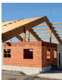
La publication du SNMI et de la FFTB "Montage et enduction des briques à joints minces" \*\* recommande d'enduire les briques Rt2 ou Rt3 avec des enduits semi-allégés de classes OC1 ou OC2 CSII ou CSIII.
