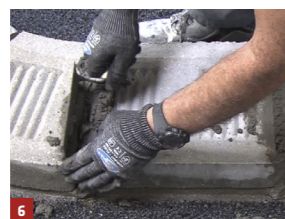
6 > Remplir les joints avec le 717 Lankoroad Bordure ou 152 Mortier Fin
