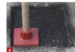
5 > Compacter à l'avancement
