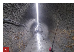
1 > Purge de l'ouvrage
