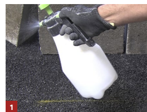
1 > Nettoyer et humidifier le support
