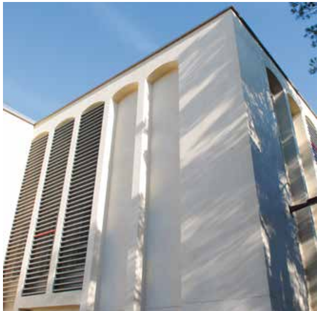
2 PARINTER RÉNOVATION utilisé sur béton
